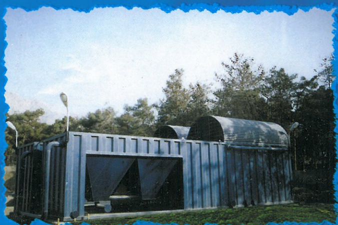
سیستم تصفیه فاضلاب RBC-150، دارای ظاهری زیبا و بدون تولید بو
